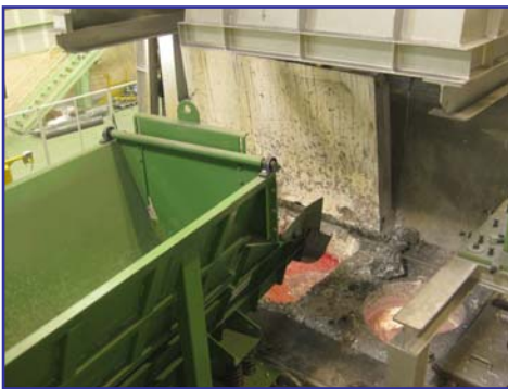
Cargador vibrante, para dosificación de chatarras densas al pozo abierto
