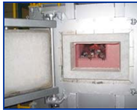
Vista interior cámara de mantenimiento.
