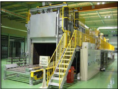
Horno de Solubilizado con puerta de carga abierta.
