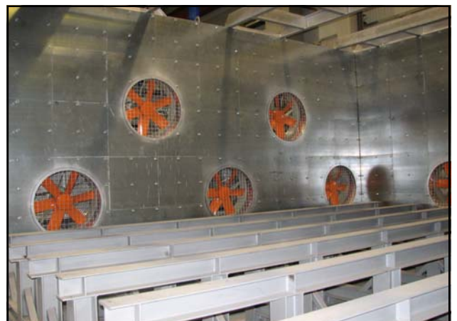
Cámara de Enfriamiento Forzado (aire).
