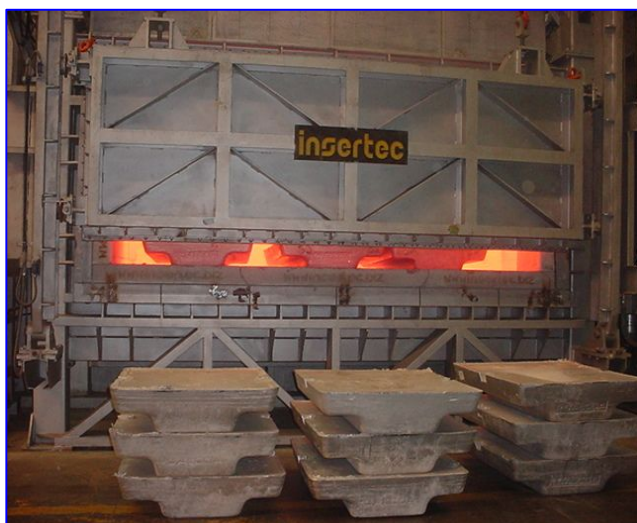
Detalhe da porta principal com batente de SIFCA
