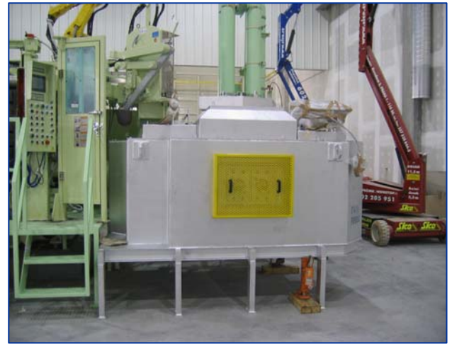
Forno de Espera IMAE situado ao pé da máquina de moldagem
