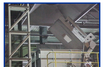
Tampa de carga sobre a torre de basculação
