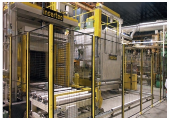
\ Vista general Instalación tratamiento térmico T7 en disposición lineal.
